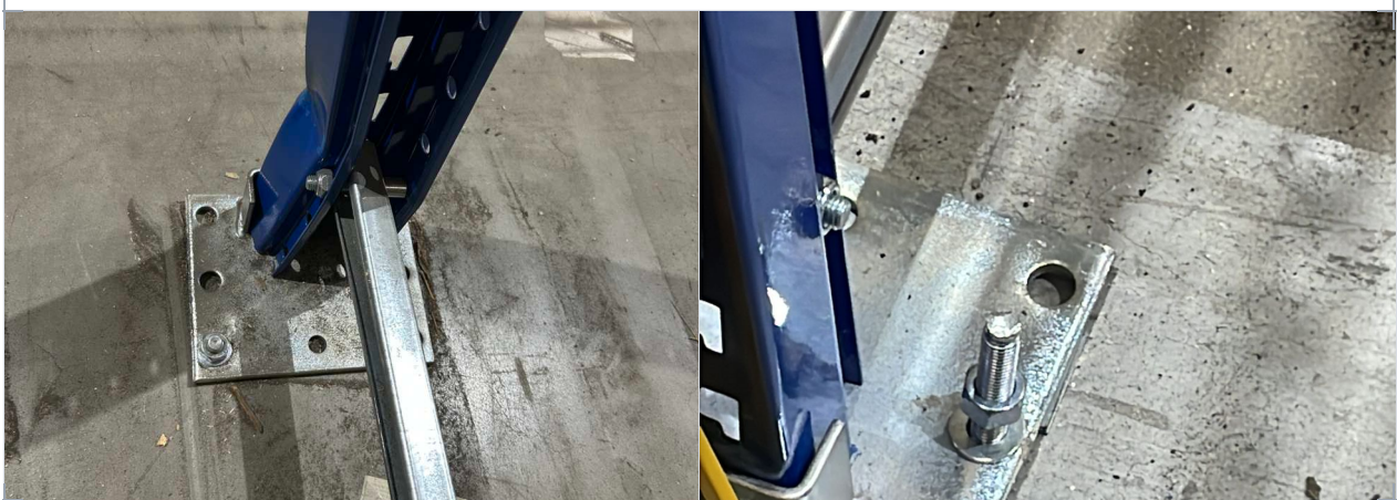
Abb. 3 – Links: verformter Ständer oberhalb der Fußplatte. Rechts: Fußplatte mit Bodenverankerung – die Stelle, an der Anfahrschäden zuerst sichtbar werden.
